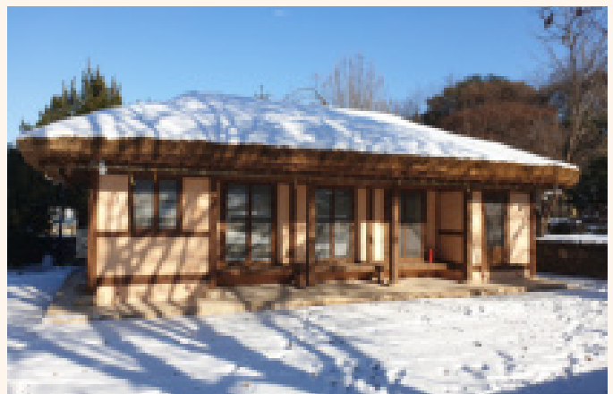
복원된 고초골 공소의 모습. (2022년 12월 초가의 공사)
