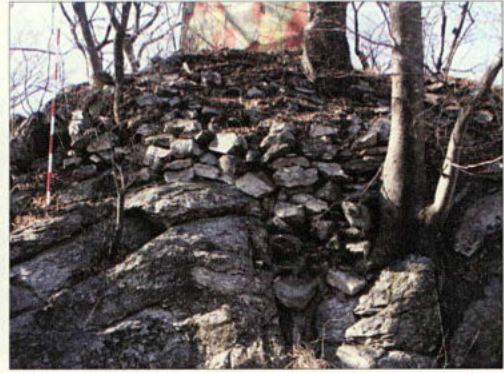
방호벽 서벽 전경
