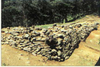
성남 천림산붕수 동북쪽 방호벽
