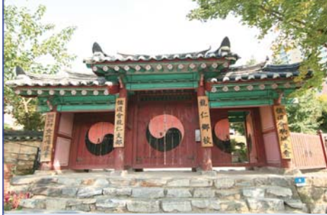
용인시 기흥구 연남동 335 (용인향교) 자료집 : 14
